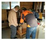
支柱の朽ちた部分は切り落とし、短くなった支柱 に柿渋を塗って防腐処理をしました。
