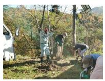
こもれび工房前にある太陽光パネルの支柱の下部が朽ちてきていたので、11月15日(日)に支柱を立て替えました。まずは、支柱を埋
